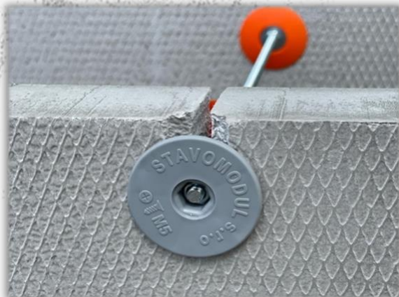
VNĚJŠÍ SPECIÁLNÍ PODLOŽKA S MATICÍ, KTERÁ PŘESNĚ FIXUJE POŽADOVANOU TLOUŠŤKU ZDIVA
