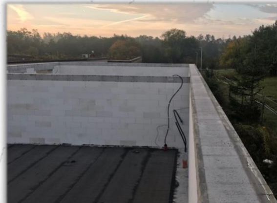
REALIZACE BEDNĚNÍ VĚNCŮ
